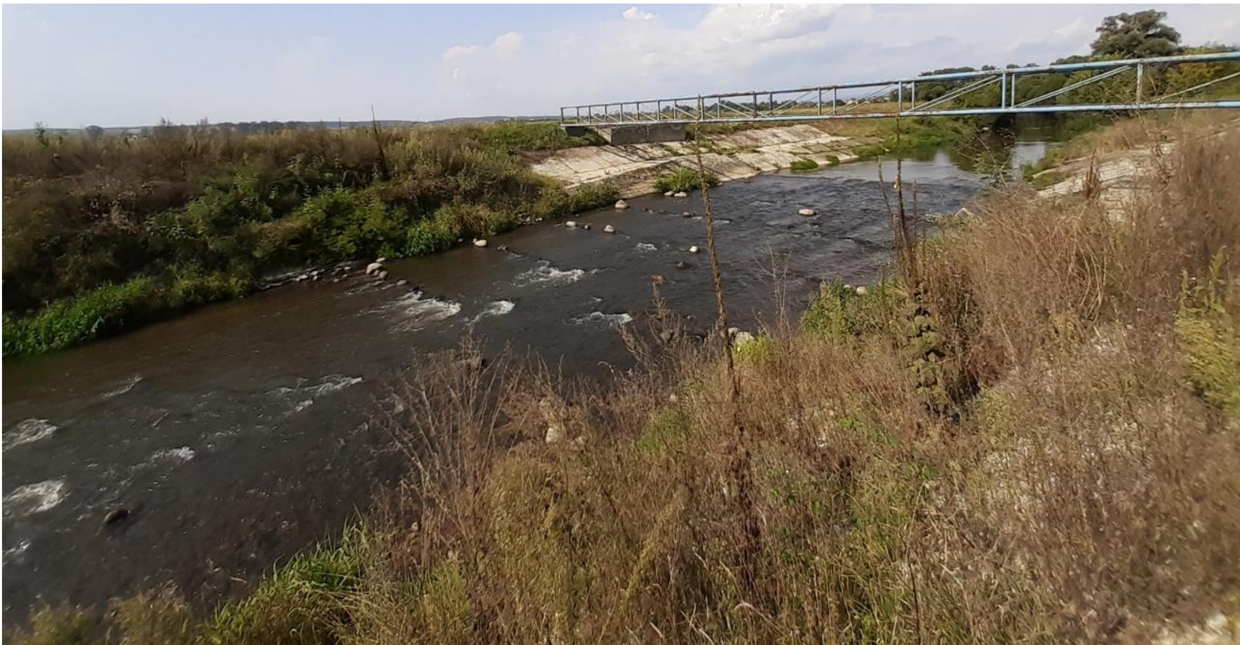
Spriechodnenie prahov na toku Rimava - Pavlovce r.km 24,984:
