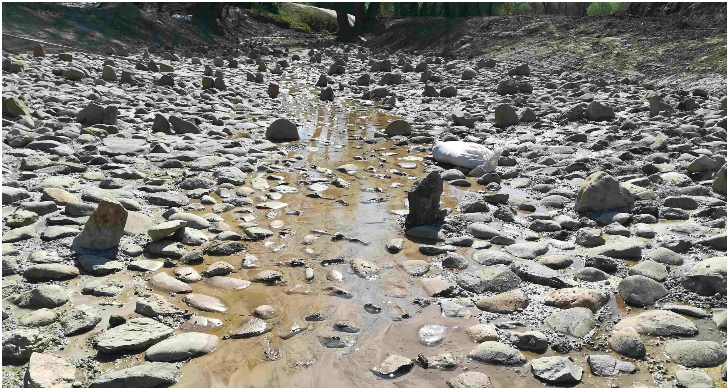
Celokorytový sklz Dudince – miskovitě a silno členité kamenné dno s oddychovými kameňmi
